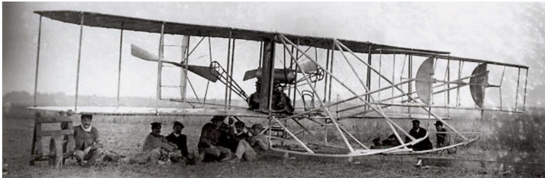
*Pendant la pluie, les mécaniciens du Flyer A n° 43 (forfait) s'abritent sous les ailes de la machine. Dépourvue de roues, la machine Wright doit glisser sur des rails au décollage, aidée d'une catapulte à contrepoids. Gabriel Voisin a longtemps critiqué ce système. (Collection Clerget).*
