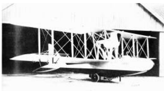
Savoï a-Marchetti S16 bis équipé ici du moteur Lorraine V12 de 400 ch (photo). (Cliché Musée de l'hydraviation).
