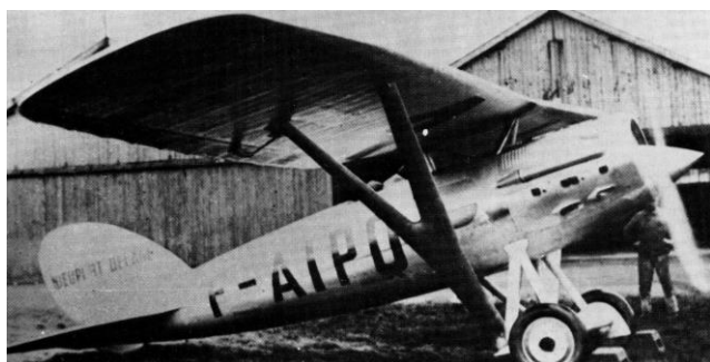
Le Nieuport-Delage NiD-623 a perdu son plan inférieur, reçu un radiateur frontal devant le moteur Lorraine. (Collection L. Rosenthal).
