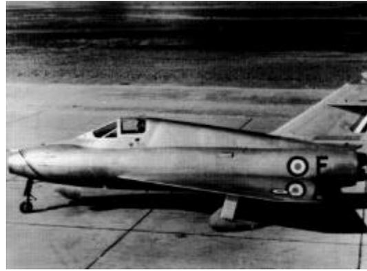
*L'intercepteur prototype SFECMAS S 1402 « Gerfaut » I, janvier 1955. Propulsé au début par un simple réacteur SNECMA Atar 101 C de 2 400 kgp, l'appareil dépasse Mach 1 et monte à 12 000 m en 5 mn 10 s.*
